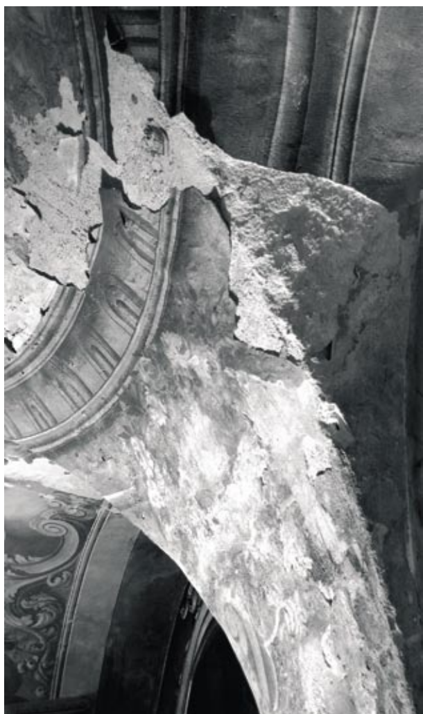
18. Deštruované omietky s Massányiho rekonštrukcion Galliartho fresky v nábehu klenby medzi lunetami v dolnom kostole, stav v roku 2007.
