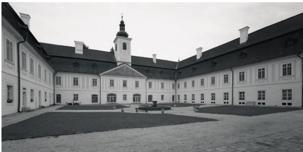
2. Blick auf den Innenhof des Koháry-Schlusses in St. Anton. Foto: D. Slivka.
