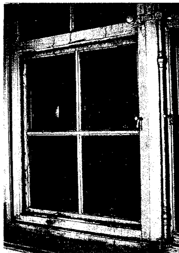
Bratislava, Primaciálny palác, druhé poschodie, systém zavierania vonkajšieho okna zo začiatku 19. storočia. Fotografia R. Kedra ml.
