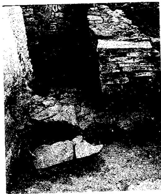
Liptovská Mara — kostol; previazanie základov pravouhlej prístavby za západným múrom sakristie a ostenie vchodu do jej suterénu. Fotografia J. Hoššu
