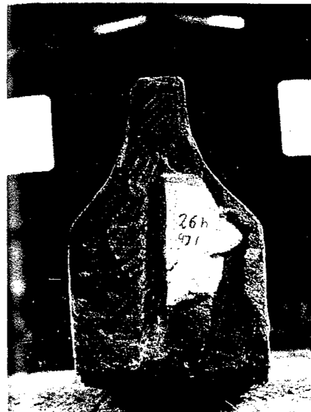
Liptovská Mara — profil klenbového rebra z presbytéria, stav po demontáži. Fotografia J. Rybárika
