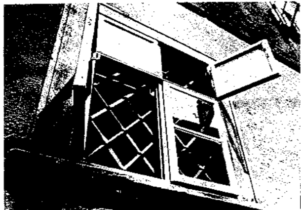
Bratislava, bývalý kláštor uršuliniek, okno na prízemí s vonkajším oknom z 20. storočia. Fotografia A. Karlikovej
