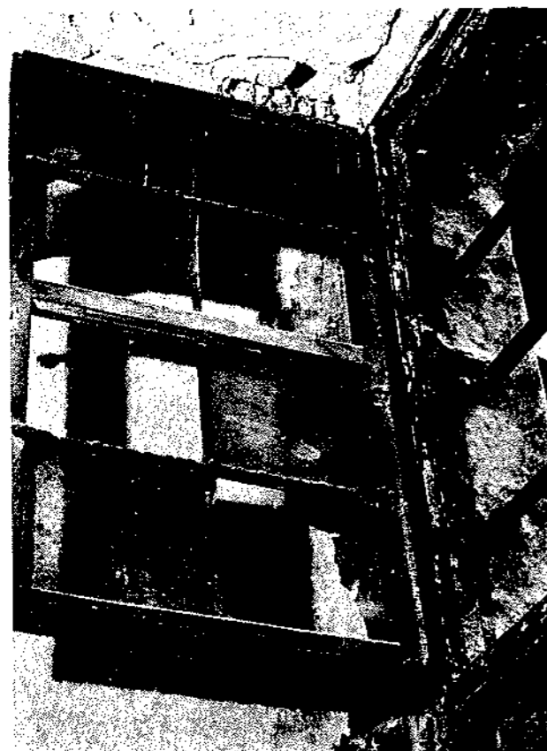
Bratislava, Jiráskova ulica 12, bývalý Pálffyho palác, svetlíkové okno so zasklením v olove a so železnou výstužou (druhá tretina 18. storočia), druhé nádvorie. Fotografia R. Kedra st.
